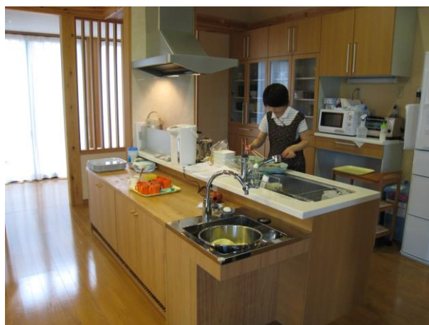
写真2 キッチンの前にカウンターを設置。少し段があるため多少使いにくい。利用者用の低い洗面台兼シンクを設けている。食器棚は3本設けられている。
